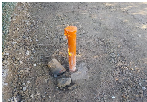
Photographie de la tête de l'ouvrage
