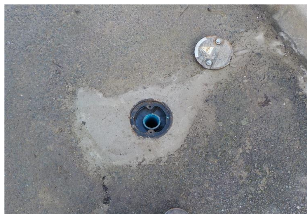
Photographie de la tête de l'ouvrage
